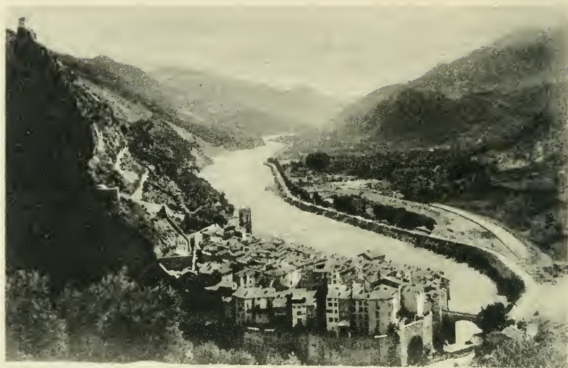
Vue générale d'Entrevaux.
